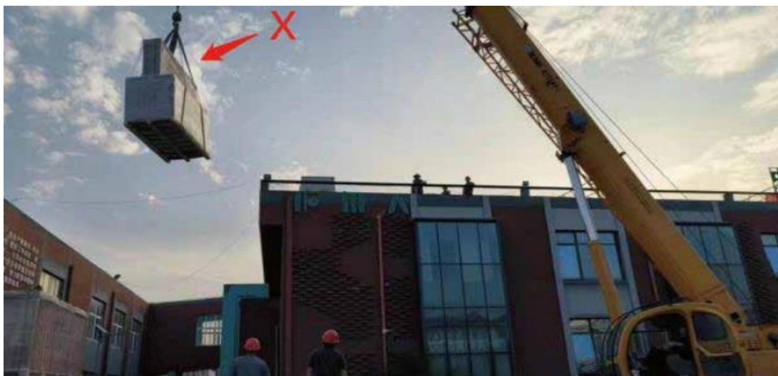
(Figura 10 Diagrama incorreto ilustrando o transporte de caixas empilhadas usando guindaste)
